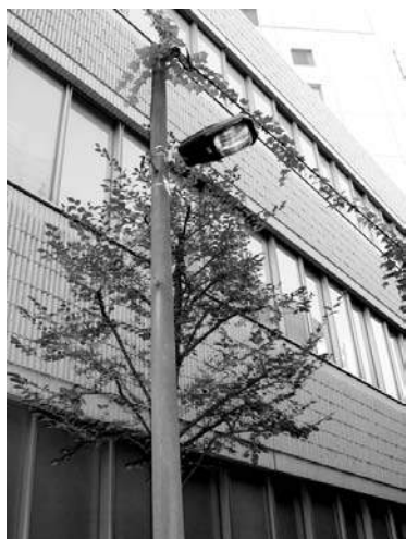
音羽1丁目の裏路地に街灯を設置しました。
